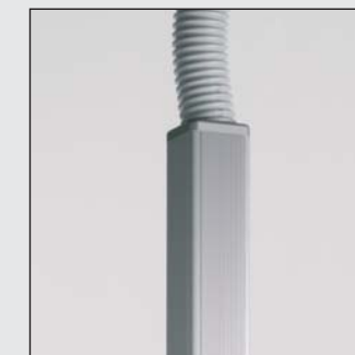
Кабели выходят из потолка внутри гофрированного шланга.
